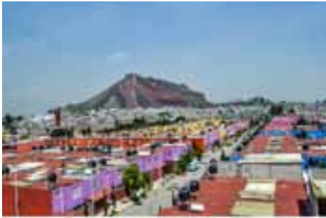
La communauté d'habitation auto-construite et auto-organisée d'Acastrinaguá
